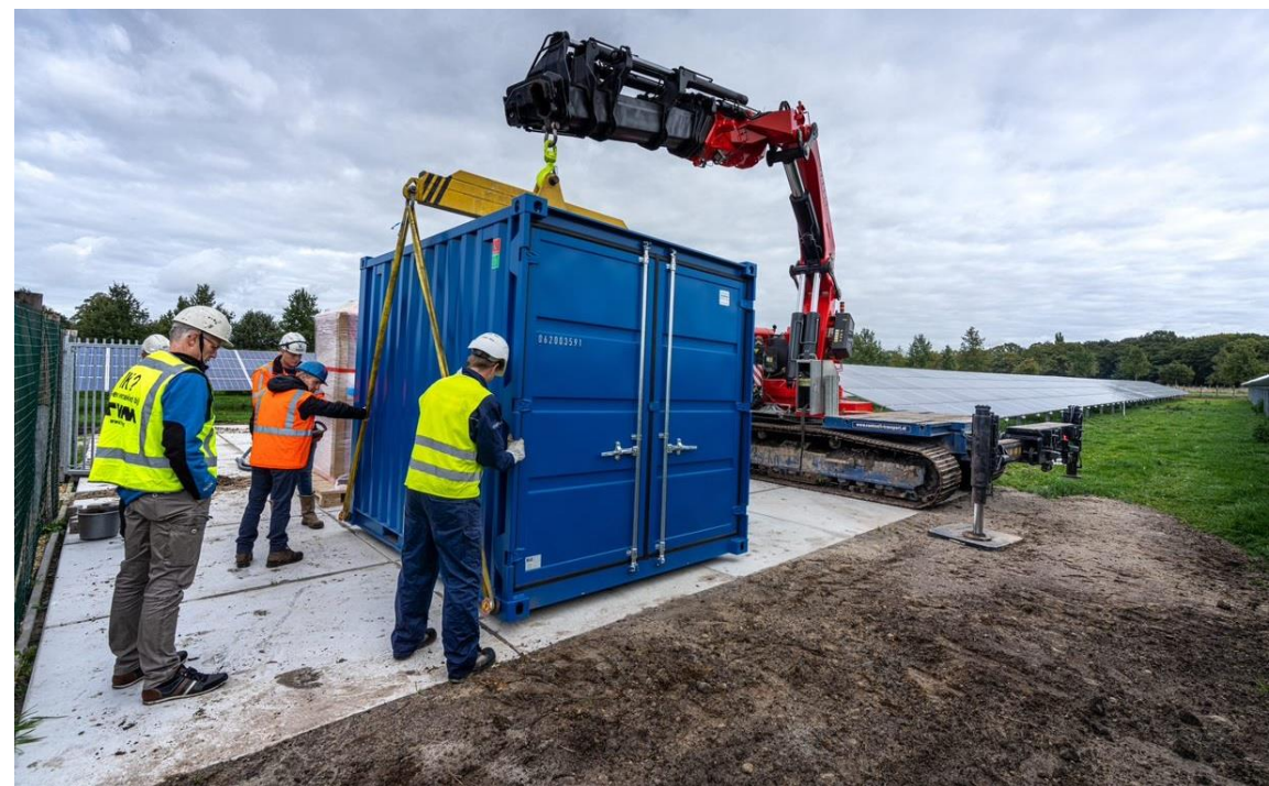
Plaatsen batterij Zonnepark Heeten, foto: TenneT
